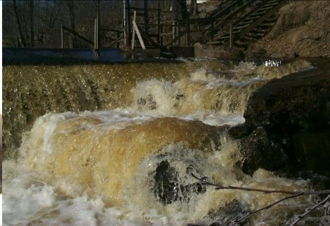
Bassängtrappa med överfall - Kvillen, Emån
