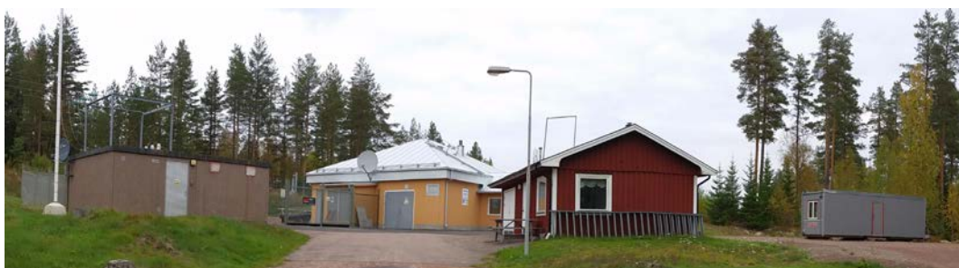
Kraftverksbyggnaderna (Foto Benedict Alexander, Lst Dalarna, 2016)
