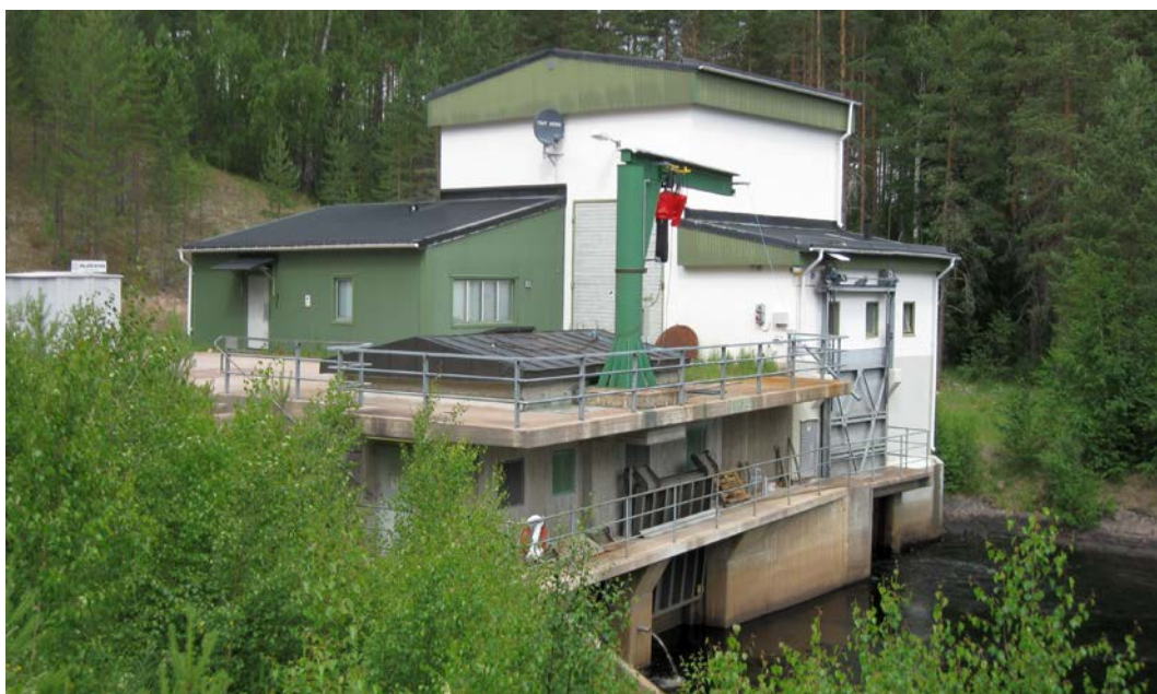
Furudal kraftverk (Foto: Anders M, Lst Dalarna 2009).
