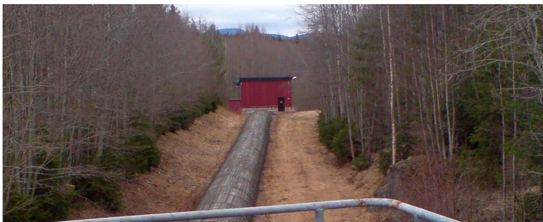
Amungens kraftverksstation samt tillhörande trätub (foto: Lst Dalarna 2010).
