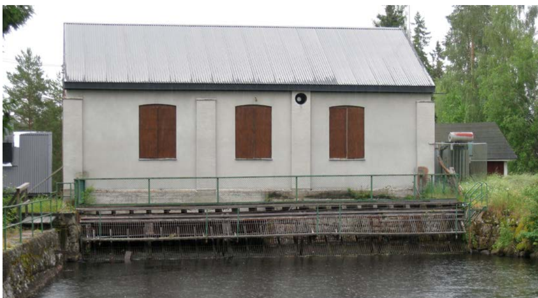
Skiffsforsens kraftverksstation (Foto: Jonas B, Lst Dalarna 2009)
