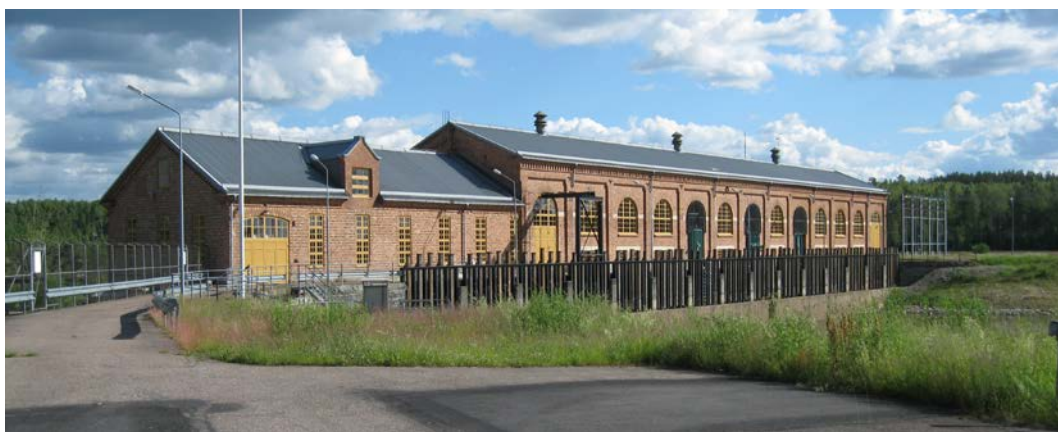
Näs gamla kraftstation (foto: Anders M, Lst Dalarna 2010).
