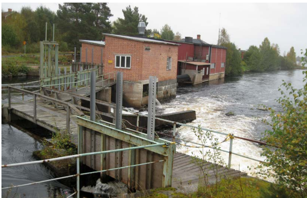
Yttertångers kraftverk och damm (Foto: Jonas B, Lst Dalarna 2009).
