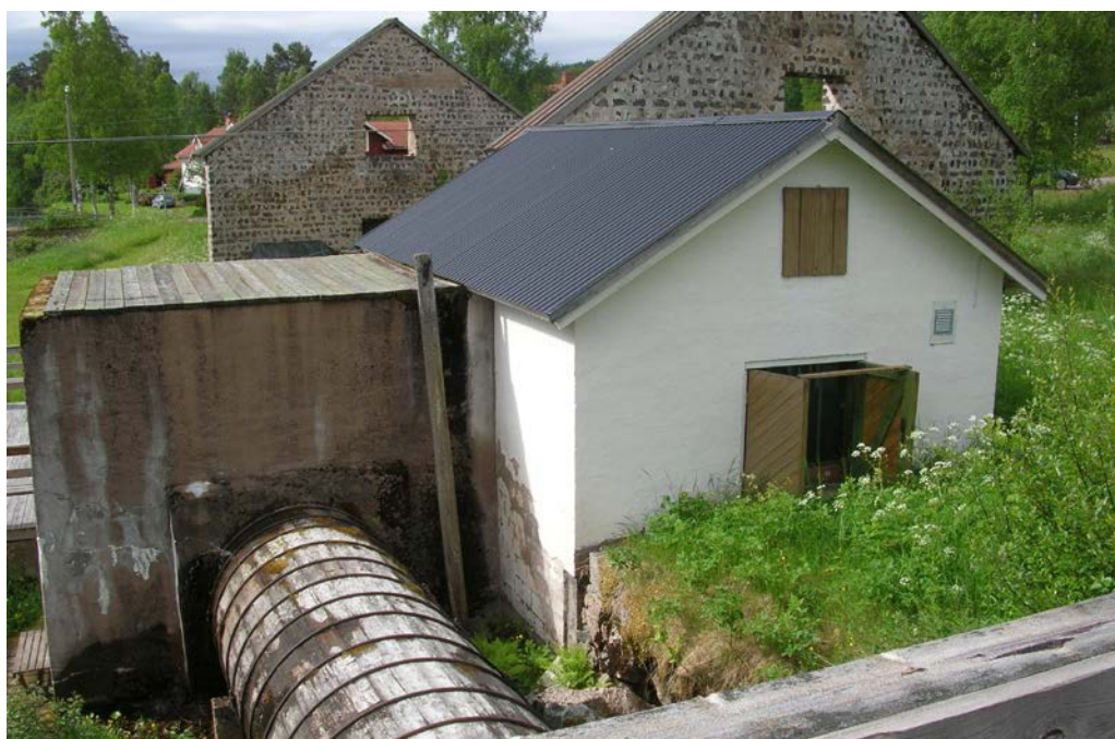
Dådrans kraftstation samt trätub. I bakgrunden syns delar av fornlämningsmiljön vid Dådrans bruk. (foto: Anders M, Lst Dalarna 2010).
