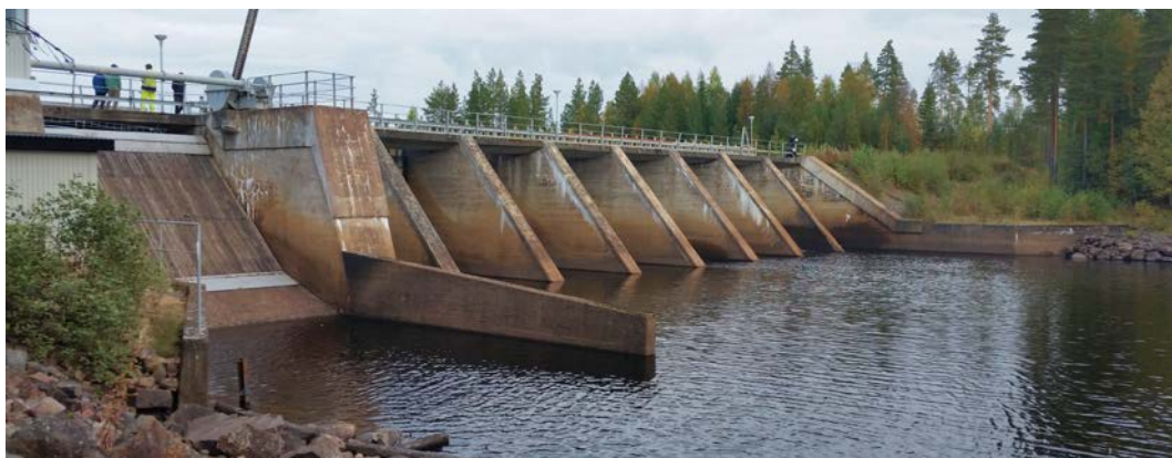
Dammvallen med flötningsutskovet till vänster. Intill denna ligger stenkistor med timmerrester. (Foto Benedict Alexander, Lst Dalarna, 2016)
