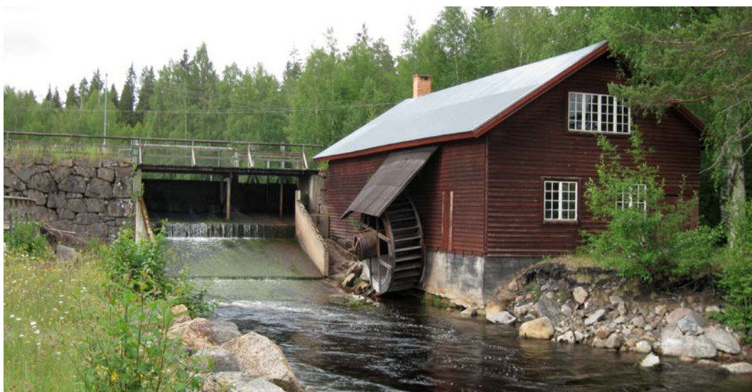
Kraftstationen brukar samma dammvall som Dådrams spiksmedja, ett byggnadsminne. Kraftstationen ligger utanför bild, till vänster (foto: Anders M, Lst Dalarna 2010).
