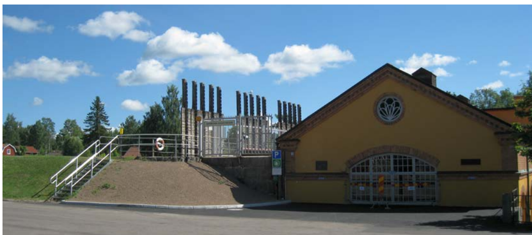
Sundborns kraftstation (foto: Anders M, Lst Dalarna 2010).
