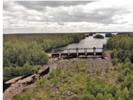
Vy över Tensmyradammen vid Lanforsens kraftverk, ett av flera hinder för den havsvandrande fisken.
