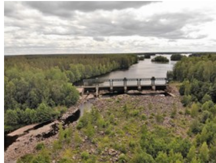
Vy över Tensmyradammen vid Lanforsens kraftverk, ett av flera hinder för den havsvandrande fisken.
