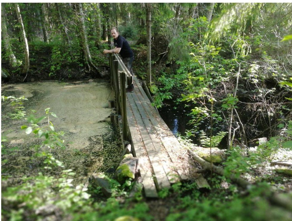
Figur 7. Bosjön regleras idag med en damm av trä. Om det är möjligt bör sjön regleras med en naturlig sjönacke.
