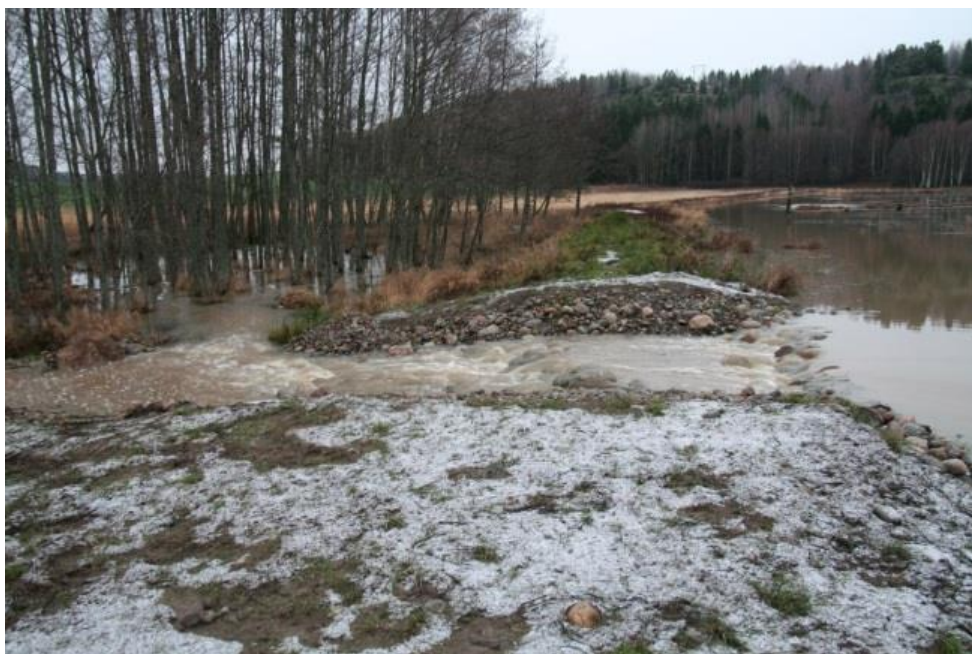
Figur 2: Omlöp vid Snäckstaviks våtmark. Ett omlöp anläggs så att det skall likna en naturlig bäckfåra med stenbotten. Oftast är det optimala ifall det finns grundläggande topografiska förutsättningar på platsen för att ta ut fallhöjden i omlöpet. En lämplig lutning är kring ca 2 % för att svagsimmande fiskarter skall kunna forcera strömmen.
