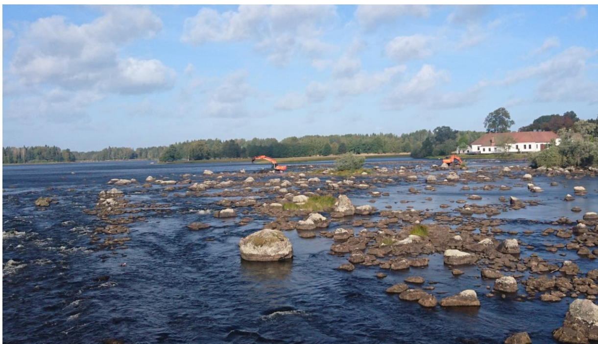
Två grävmaskiner restaurerar forsarna vid Gysinge.
